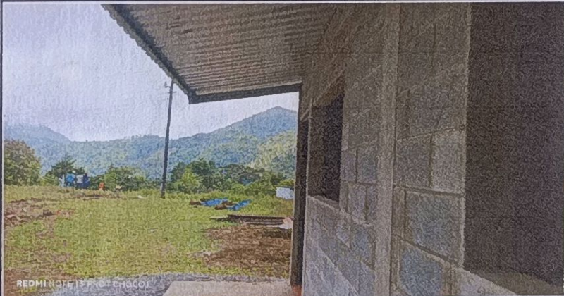
Foto 6: MODULO DE AULAS - mejoramiento de las instalaciones de preprimaria.
