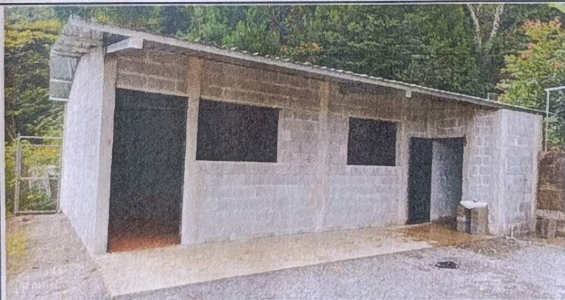
Foto 5: MODULO DE AULAS - Mejoramiento de pintura del aula
