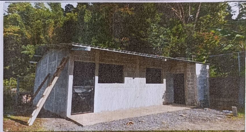
Foto 4: MODULO DE AULAS - mejoramiento de puerta y ventana
