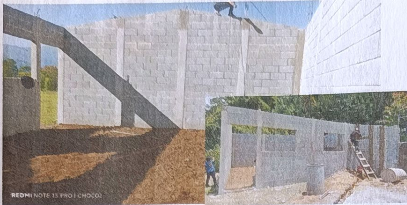
Foto1: MODULO DE AULAS - mejoramiento de puerta y piso y pared
