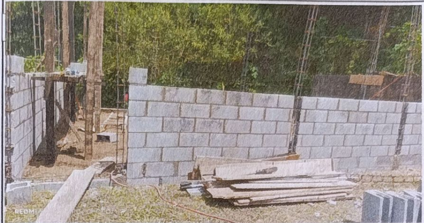
Foto 2: MODULO DE AULAS - predio en constucción de pared de lamina a pared de block
